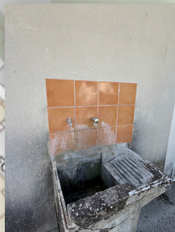
Derrière la buvette du terrain de boule (Place de la mairie)
